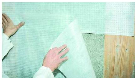
**Propriétés :** Grâce à sa transparence, il permet une visualisation parfaite du remplissage du caisson pendant l'insufflation de la cellulose THERMOFLOC. Son niveau de perméance (équivalent lame d'air Sd: 10 m) répond aux préconisations de l'Avis Technique du CSTB pour THERMOFLOC.
