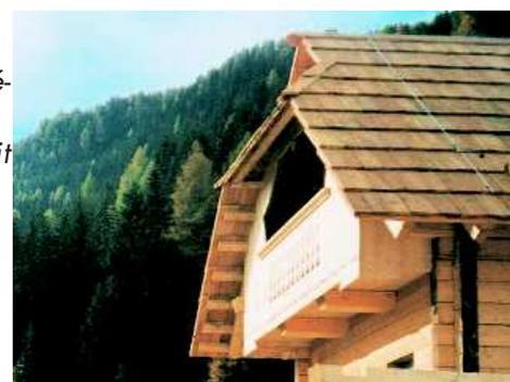
**BARDEAU DE PXD TREMPÉ :** tuiles de bois découpées dans du panneau de fibres de bois haute densité trempé (PXDT)
